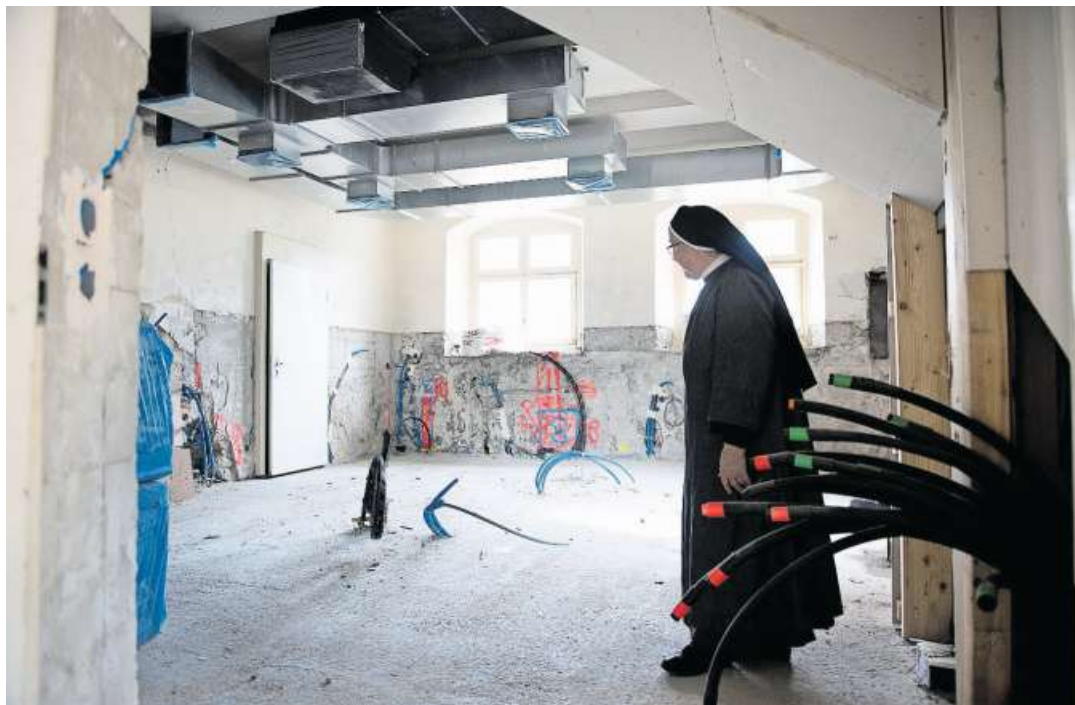
Äbtissin Pia Habermacher steht in der Küche des künftigen Benediktinischen Zentrums. Noch gibt es viel zu tun. Bild: Corinne Glanzmann (Sarnen, 2. Oktober 2018)
